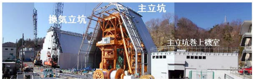
(2) 地上設備構築状況 (H16年12月28日現在)
