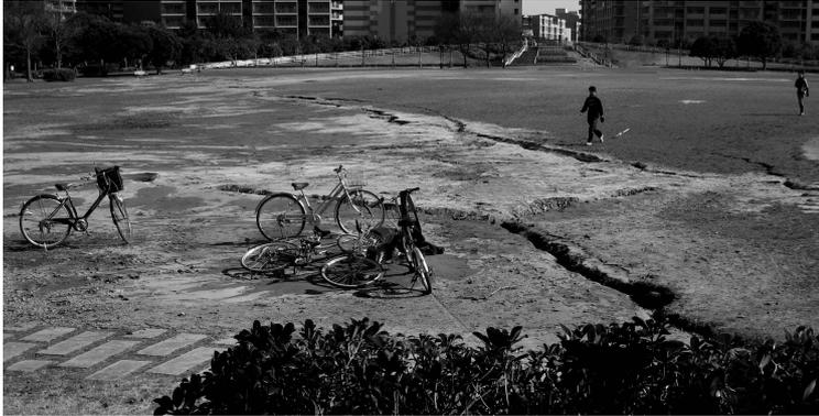
写真：液状化ゾーンにおける断層（延長約120m、落差約20cm、開口性）
