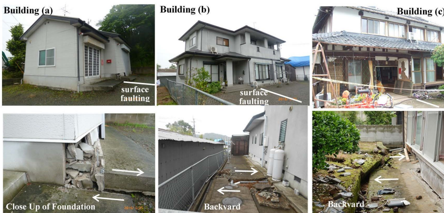
(1) 古い在来木造住宅 (2) 新しい軽量鉄骨住宅 (3) 非常に古い伝統木造住宅 写真1 御船町高木地区における地表地震断層直上の建物被害の例
