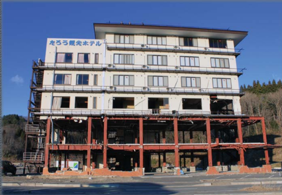
津波被災遺構として重要な 宮古市田老の観光ホテル
