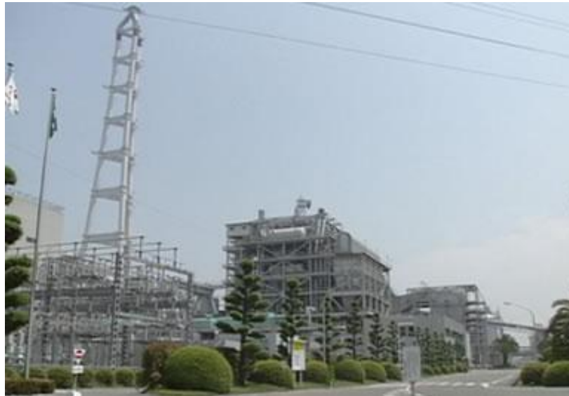
石炭火力発電所（愛媛県西条市）
