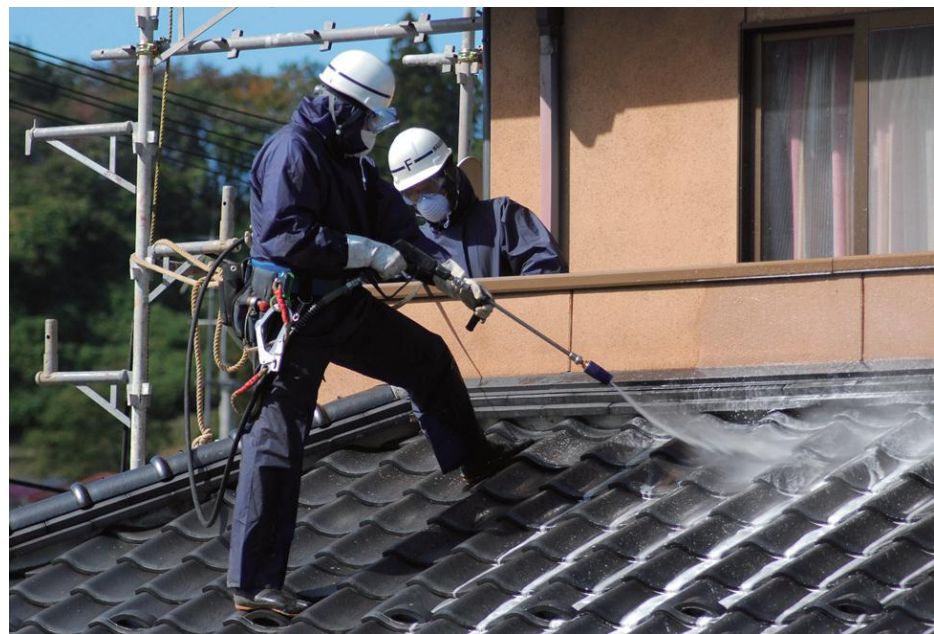
建物の屋根の洗浄(環境省HPより)
