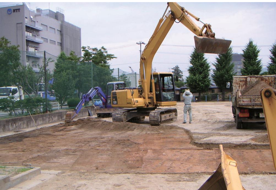
校庭表土の削り取り(環境省HPより)
